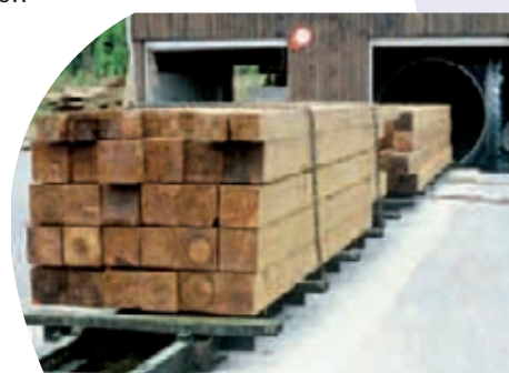
Procédé de traitement des bois par autoclave
