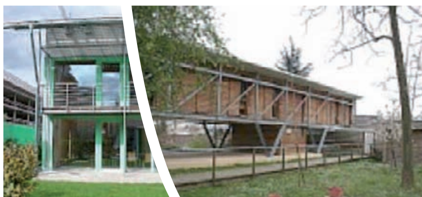
Construction sur poteaux béton
