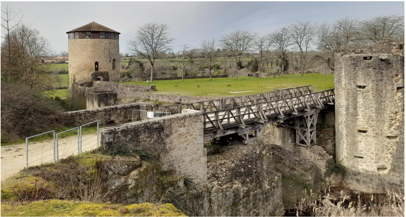
Passerelle du château de Parthenay (Source : CC Parthenay-Gâtine)
