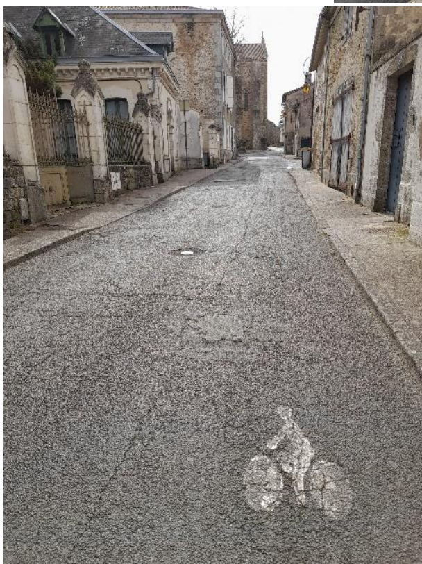
Bande cyclable Rue de la Citadelle sur une voirie étroite et dégradée, ne permettant pas un parcours sécurisé pour les cyclistes (Source : CC Parthenay-Gâtine)
