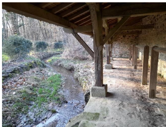
Lavoir qui se situe route de Fenioux (Source : CC Parthenay-Gâtine)
