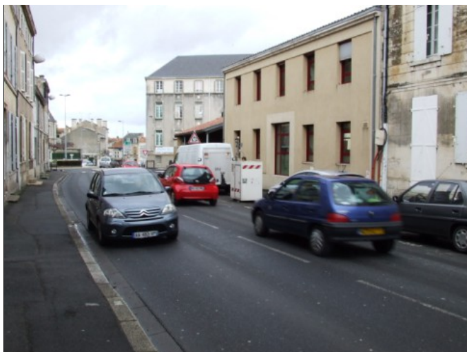
Illustration 7: Emplacement de la station rue du Général Largeau
