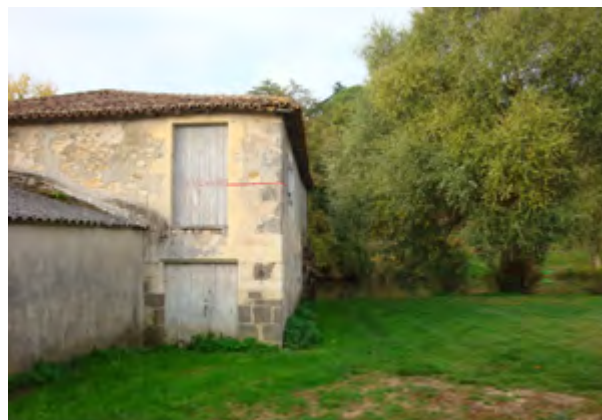
Inondation du Thouet de janvier 1961 Repère de crue à Saint-Loup Lamairé
