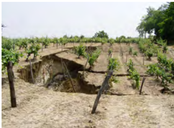
Effondrement lié à une cavité dans une vigne à Tourtenay
