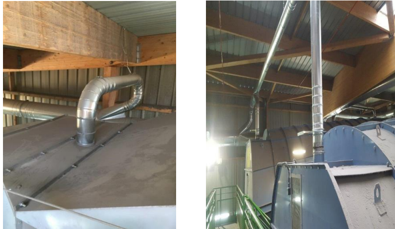
Figure 33 - Bouches d'aspiration de différents points
