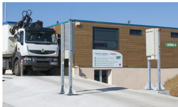
Figure 41 : Exemple portique de détection (source : setec)
