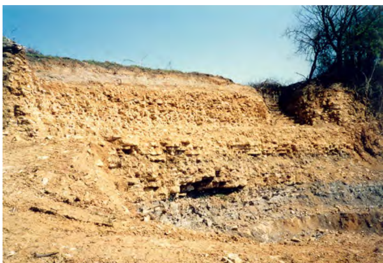
Figure 43. Travaux de terrassement réalisés sur les sites n°1 [en haut] et n°2 [en bas] préalablement à la création de la Réserve Naturelle du Toarcien.
