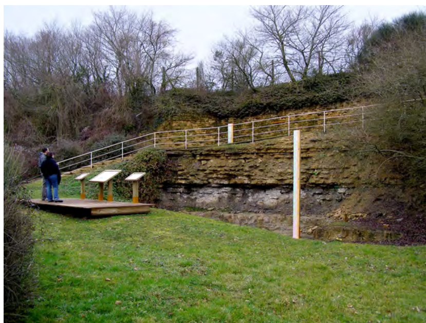
Figure 44. Équipements en place sur le site n°2 de la réserve naturelle : garde-corps, mâts en aluminium (2), platelage avec pupitres de lecture (3).
