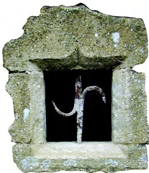
Figure 36. Fenêtre avec linteau monolithe à accolade appareillée en « grison » (XV e -XVI e s.). (photo : F. Raynard)
