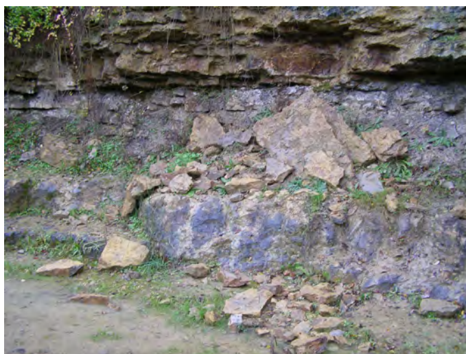
Figure 46. Surplomb et éboulements gravitaires au niveau du front de taille sur le site n°2 de la réserve naturelle.
